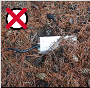
Netzteil vergraben Power supply buried Enterrer la source d'alimentation
